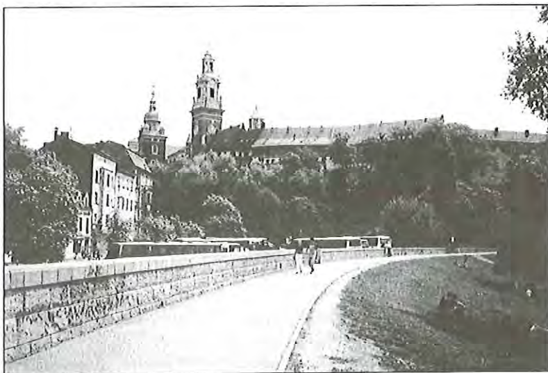
Fot. 3. Mur na koronie wału - nowe zabezpieczenie, fot. K. Pawłowska Photo 3. Wall on the embankment – new protection (photo by K. Pawłowska)
